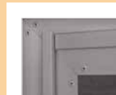
Rám ocelový zinkovaný obložený hliníkovým profilem
