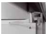
Aretace křídel zamezí zavření křídel vrat při průjezdu
